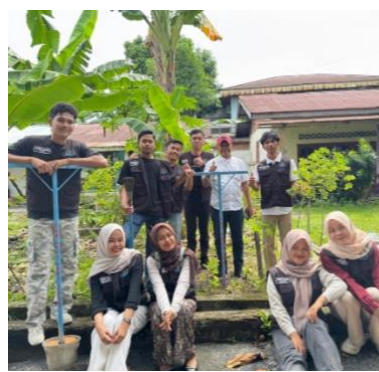
Gambar 10 Pemasangan di Jalan Thamrin Ujung
