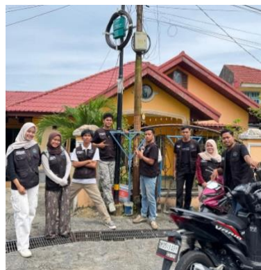
Gambar 14 Pemasangan di Jalan Dr. Susilo, Gang Indragiri
