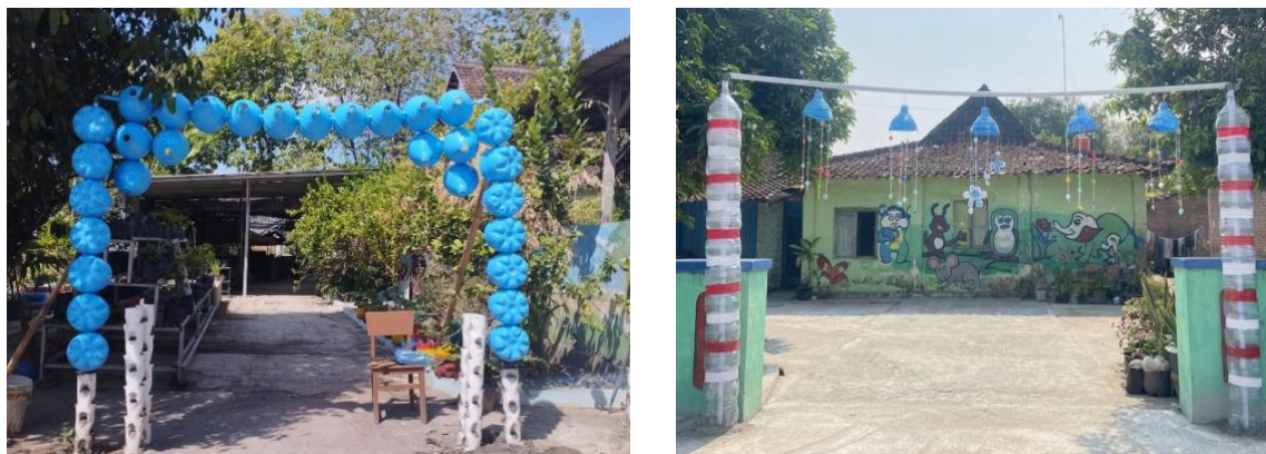
Gambar 4. Proses pemasangan gapura berbahan limbah galon plastik bekas pada Taman Hatinya PKK Desa Trasan dan Taman Hatinya RW 05.
