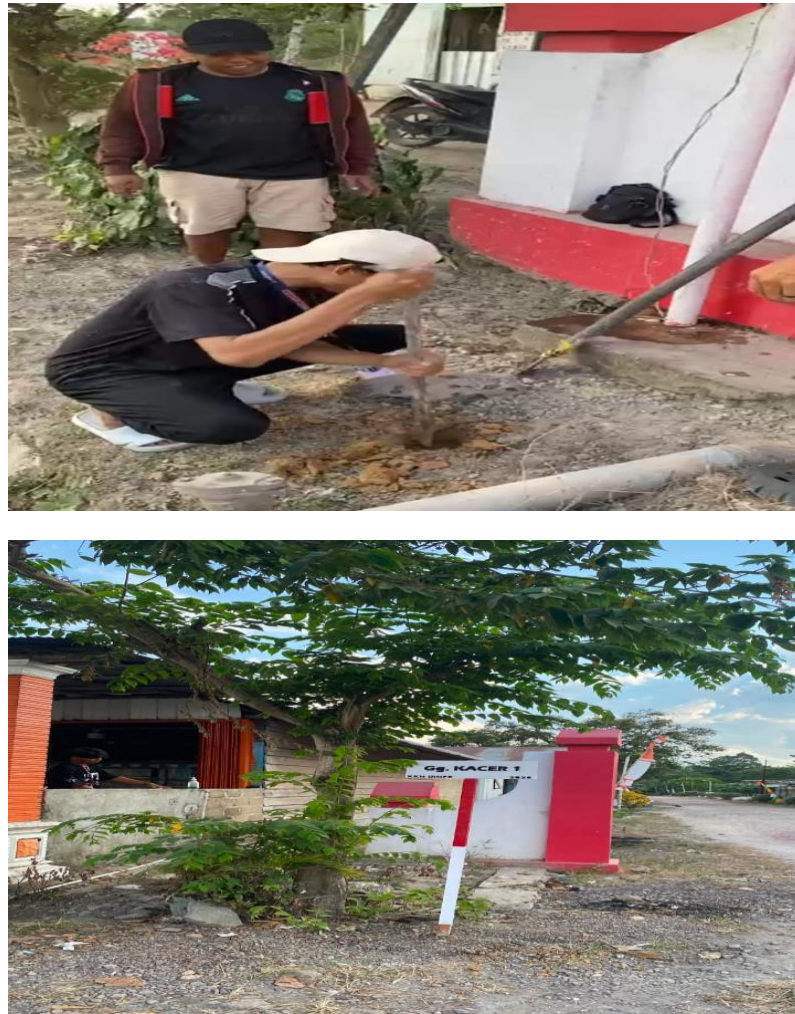
Gambar 3. Hasil Pemasangan Plang
